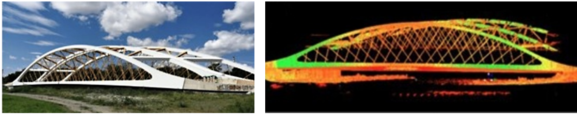
Obr. 6. Bezkontaktné terestrické laserové skenovanie a meranie deformácií inžinierskych konštrukcií
