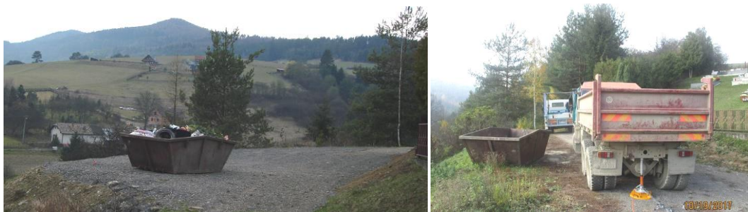
Obr. 13 Pohľady na rekonštruovanú MK2 v Pekline dňa 12. 10. 2015
