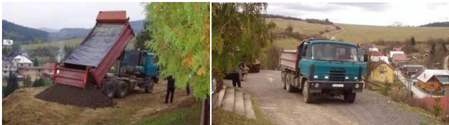
Obr. 12 Pohľady na rekonštruovanú MK2 v Pekline dňa 3. 10. 2015
