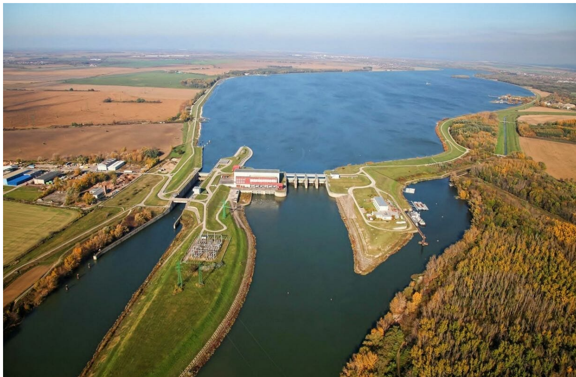
Obrázok 3. Priehradný múr a pohľad na plavebnú komoru - vodná nádrž Kráľová
